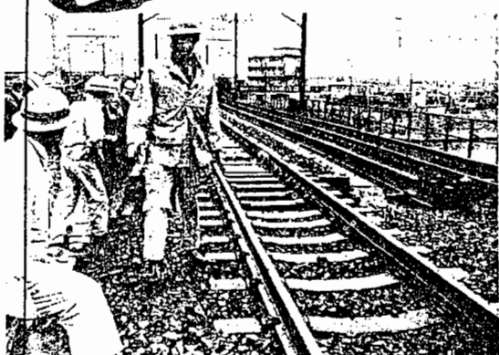
ひびの入ったレールの補修点検をする係員
