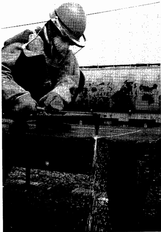
炎天下での切断作業。マスクを着けてはいるが、ガスには全く無意味。
