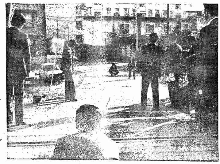
(踏切附近での現場検証 1/4)
