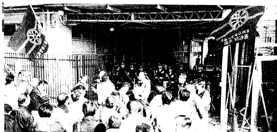
四月一日千葉運転区
