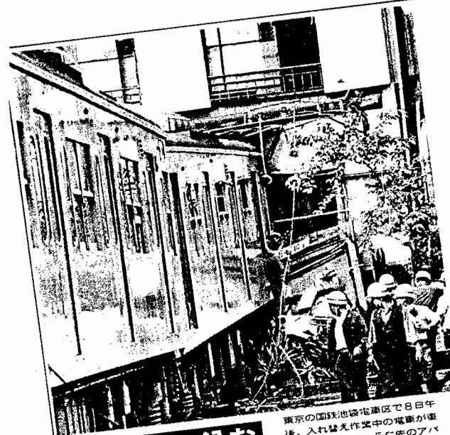
国電、突っ込む 東京の国鉄池袋電車区で8日午後、入れ替え作業中の電車が車止めを乗り越え、5両先のアバウトに突っ込んで、一階部分を壊した。幸いけが人はなかったが、もしアバウトに人がいたら…… （5月8日 池袋電車区、事故現場）
